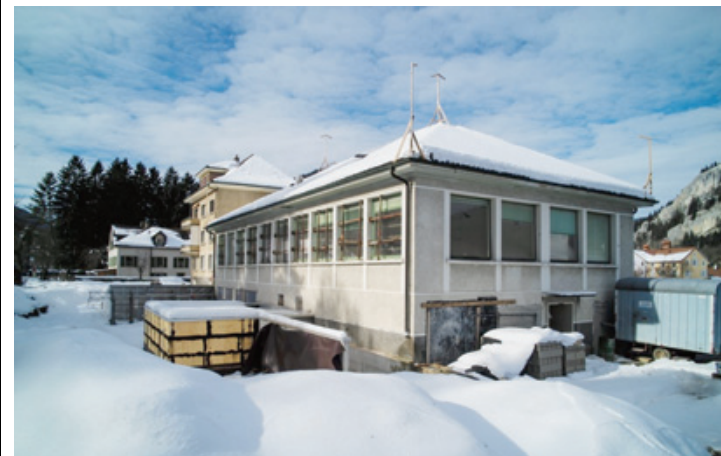
L'ancienne usine du CPHM. On voit les gabarits pour l'exhaussement du toit afin d'y accueillir le cabinet médical de groupe. CHRISTIAN GALLEY
